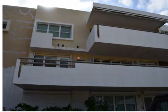
Foto 2: Se observó resanamiento de grietas en el muro compartido entre el edificio 3 (C) y 4 (D). También se observó aplicación de primer en el primer nivel del edificio.
