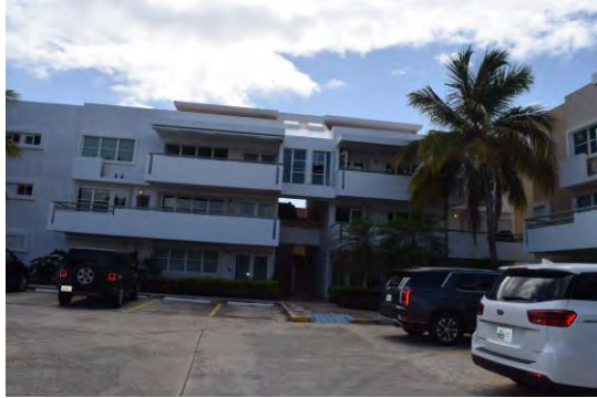
Foto 1: Fachada frontal del edificio 3 (C).
