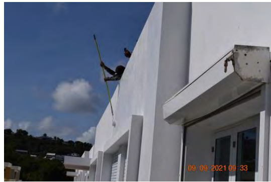
Foto 4: Se observaron trabajadores realizando labor de aplicación de segunda capa de pintura en el lado oeste del edificio 5 (E).
