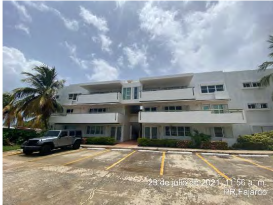
Foto 14: Lado oeste del edificio 5 también conocido como edificio E.
