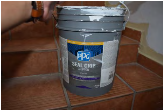
Foto 7: Material de primer utilizado de aplicación en los muros previo a la pintura. (SEAL GRIP – GRIPPER 17-921XI)
