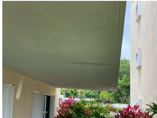
Foto 6: Se observó que se realizó reparación de grietas en el lado oeste del edificio.
