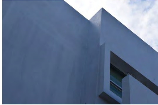
Foto 2: Se observó aplicación de primer en la mayoría de los muros del edificio.
