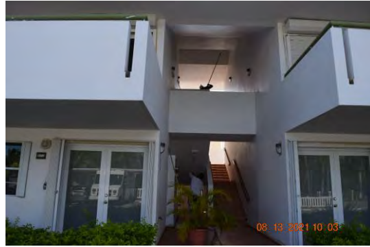
Foto 2: Se observó trabajadores realizando labor de aplicación de pintura en el interior del edificio.
