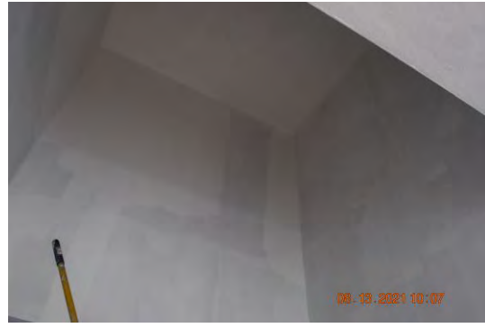
Foto 6: Se observó trabajador realizando labor de aplicación de pintura en techo interior del edificio.
