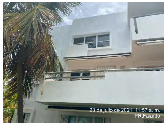
Foto 17: Se observó que se realizó aplicación de primer en el lado oeste del edificio.
