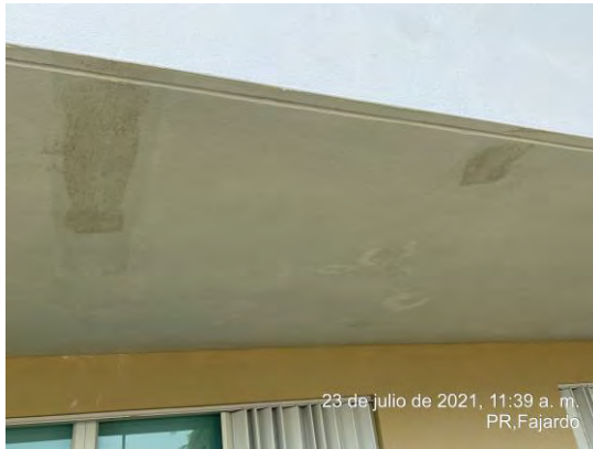
Foto 11: Se observó que se realizó reparación de grietas en el lado oeste del edificio.
