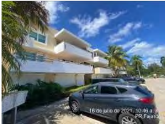
Foto 13: El contratista SP no estaba en el área de trabajo, no se observó que se haya realizado trabajo.
