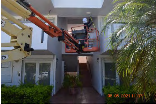
Foto 5: Se observó trabajador realizando labor de aplicación de pintura en área compartida frente a las escaleras.
