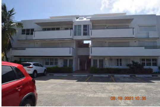
Foto 7: Perspectiva del lado este del edificio 5 (E).
