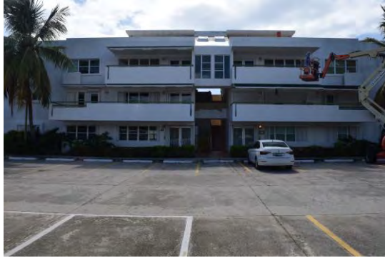
Foto 5: Fachada frontal del edificio 4 (D).
