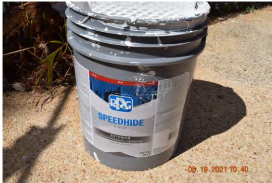
Foto 3: Material utilizado par la aplicación de pintura. (SPEEDHIDE 6-610XI)
