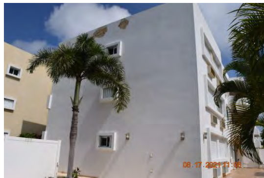
Foto 4: Se observó parte del edificio con ambas capas de pintura en el lado norte del edificio.
