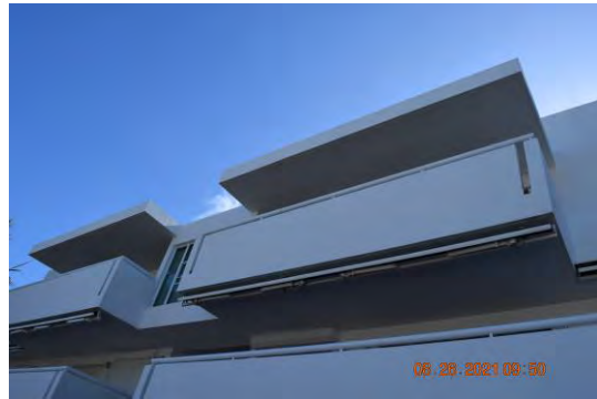
Foto 2: Se observó la mayoría de los "railings" de los balcones del edificio terminados con labor de acondicionamiento de superficies de metal.
