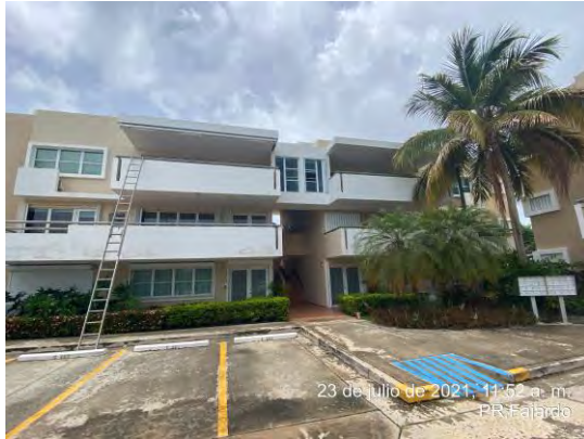
Foto 1: Lado oeste del edificio 3 también conocido como edificio C.
