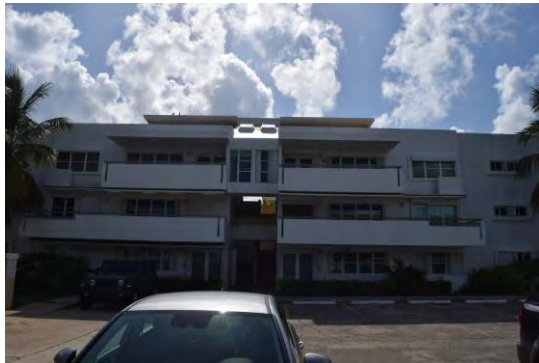
Foto 19: Fachada frontal del edificio 5 (E). Se observó aplicación de primer en la fachada frontal del edificio 5 (E).
