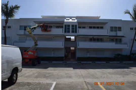
Foto 1: Perspectiva del lado este del edificio 4 (D).
