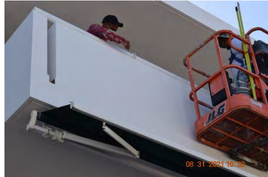
Foto 2: Se observó trabajador realizando labor de acondicionamiento de superficies de metal en balcón del edificio 4 (D).
