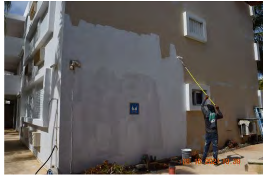
Foto 10: Se observó trabajador realizando labor de aplicación de primer en la fachada izquierda del edificio.
