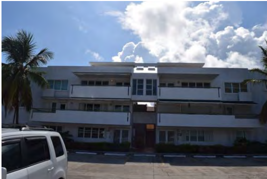
Foto 5: Fachada frontal del edificio 4 (D).
