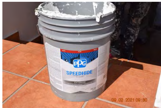
Foto 4: Material utilizado para la aplicación de pintura en los recortes de los muros del edificio 3 (C). (SPEEDHIDE 6-610XI)
