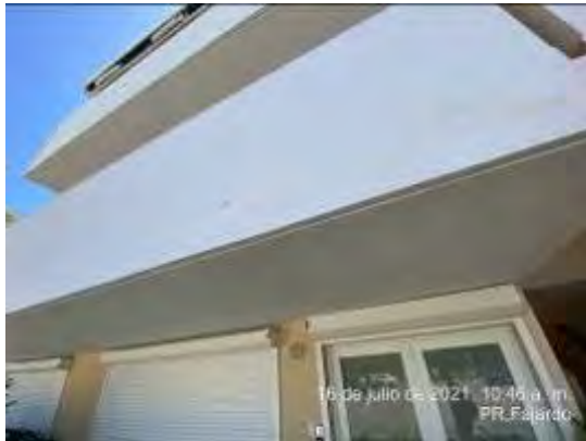
Foto 11: El contratista SP no estaba en el área de trabajo, se observó que realizó limpieza con máquina de presión en el lado este del complejo.
