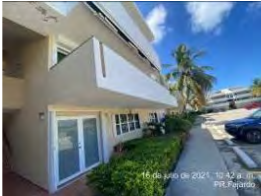
Foto 3: El contratista SP no estaba en el área de trabajo, se observó que realizó limpieza con máquina de presión en el lado este del complejo
