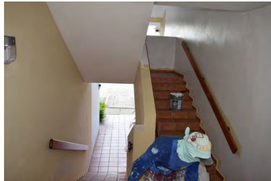
Foto 6: Se observó trabajadores realizando labor de aplicación de primer en área común de escaleras del edificio.
