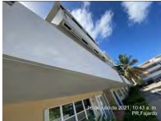
Foto 6: El contratista SP no estaba en el área de trabajo, se observó que realizó limpieza con máquina de presión en el lado este del complejo
