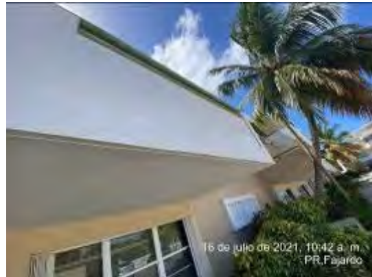
Foto 4: El contratista SP no estaba en el área de trabajo, se observó que realizó limpieza con máquina de presión en el lado este del complejo
