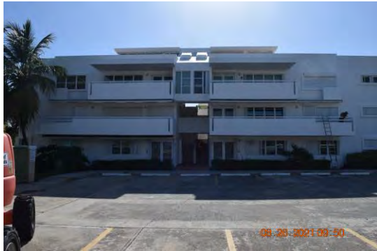
Foto 1: Perspectiva del lado este del edificio 5 (D).
