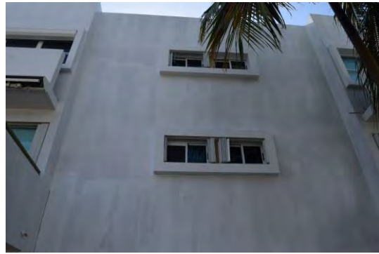
Foto 18: Se observó trabajo de aplicación de primer en el muro compartido entre edificio 4 (D) y 5 (E).
