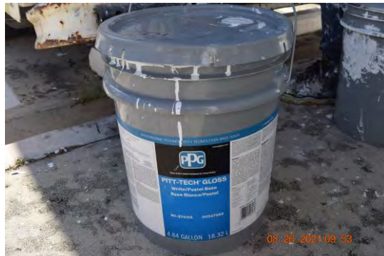
Foto 4: Material utilizado para la aplicación de pintura en las superficies de metal (railings). (PITT-TECH GLOSS [90-374/05 - 00337993])
