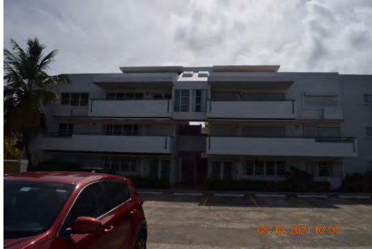
Foto 9: Fachada frontal del edificio 5 (E).
