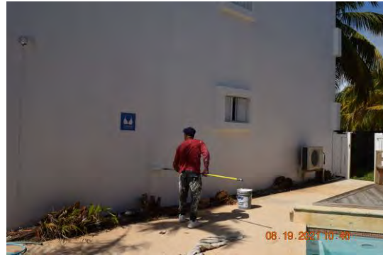
Foto 2: Se observó trabajador realizando labor de aplicación de pintura en el lado sur del edificio.
