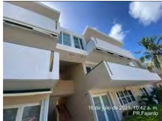
Foto 2: El contratista SP no estaba en el área de trabajo, se observó que realizó limpieza con máquina de presión en el lado este del complejo
