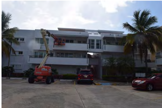
Foto 1: Fachada frontal del edificio 3 (C).
