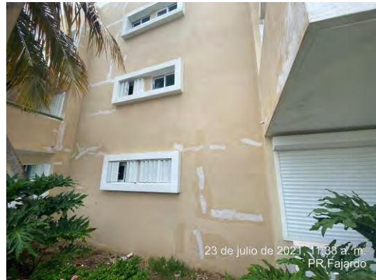
Foto 4: Se observó que se realizó reparación de grietas en el lado oeste del edificio.
