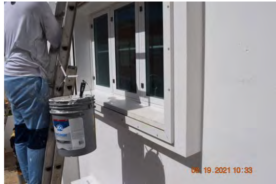
Foto 2: Se observó trabajador realizando labor de aplicación de pintura en el lado oeste del edificio alrededor de las ventanas del segundo nivel.
