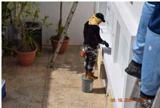
Foto 3: Se observó trabajador realizando labor de aplicación de pintura en el lado oeste del edificio alrededor de las ventanas del primer nivel.
