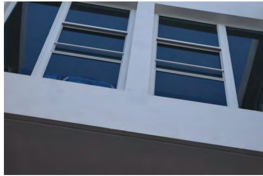
Foto 14: Se observó resanamiento de grieta horizontal y aplicación de primer en la parte inferior del muro compartido entre los apartamentos del tercer nivel del edificio.
