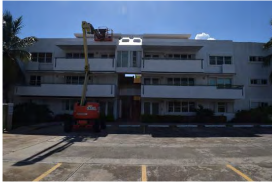
Foto 9: Fachada frontal del edificio 5 (E). Se observó la utilización del elevador de brazo mecánico para acceder la terraza del edificio.
