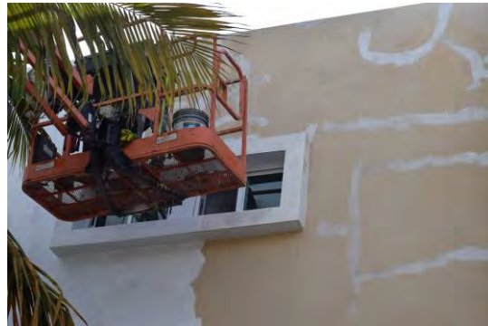
Foto 4: Se observó trabajador aplicando primer en la parte superior del muro compartido entre los edificios 3 (C) y 4 (D). El trabajador realizaba la labor desde el interior de una plataforma articulada.
