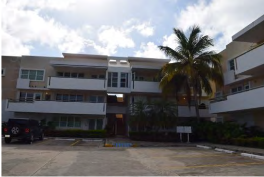
Foto 1: Fachada frontal del edificio 3 (C).
