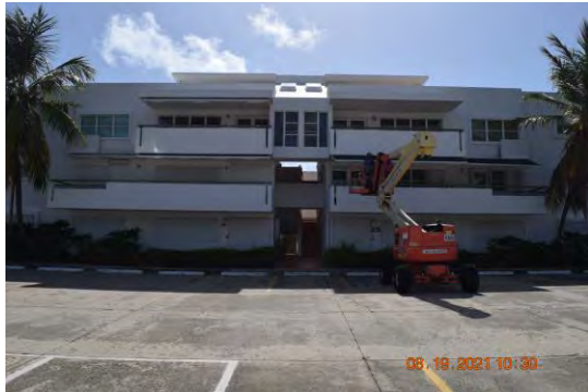
Foto 1: Perspectiva del lado este del edificio 4 (D).
