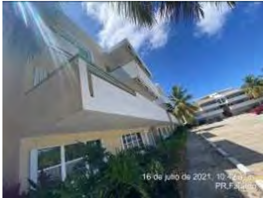
Foto 5: El contratista SP no estaba en el área de trabajo, se observó que realizó limpieza con máquina de presión en el lado este del complejo
