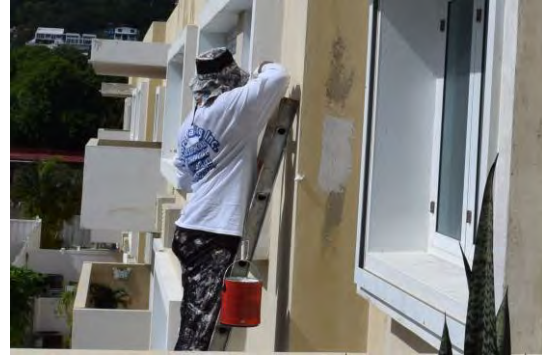
Foto 28: Material utilizado para el resanamiento de grietas fue Caulk & Sealant.
