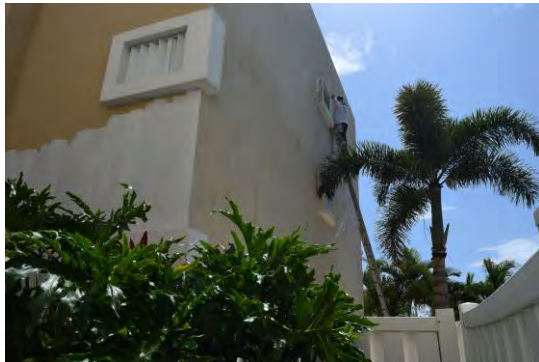
Foto 3: Se observó a trabajador realizando labor de resanamiento en grietas en el muro de la fachada derecha de edificio.
