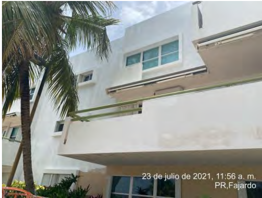
Foto 13: Se observó que se realizó labor de aplicación de primer en el lado oeste del edificio.
