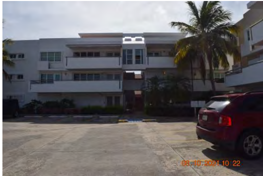
Foto 1: Fachada frontal del edificio 3 (C).
