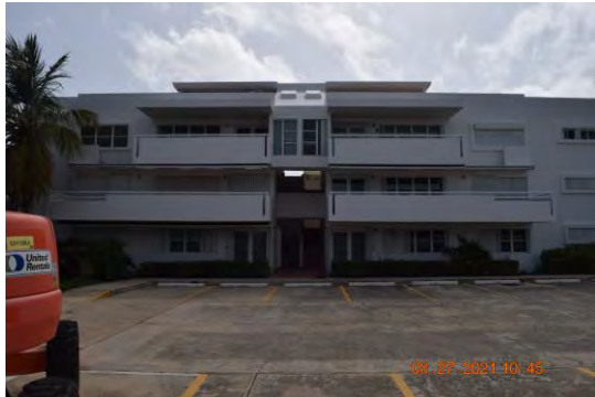
Foto 1: Perspectiva del lado este del edificio 5 (D).
