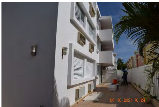
Foto 3: Se observaron trabajadores realizando labor de pintura en la fachada trasera del edificio.
