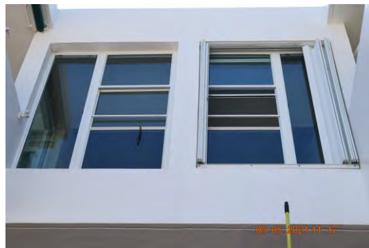
Foto 4: Se observó que la grieta horizontal y la delaminación del muro que divide los apartamentos del tercer nivel del edificio fue corregida.
