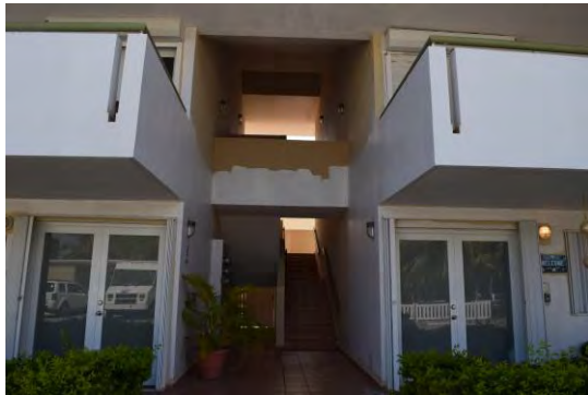
Foto 7: Se observó aplicación de primer en la mayoría de los muros del edificio.
