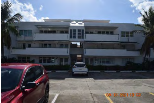
Foto 1: Perspectiva del lado este del edificio 4 (D).
