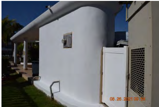
Foto 8: Se observó aplicación de "primer" en la gran mayoría de los muros del edificio de los baños en las áreas comunes de la piscina.
