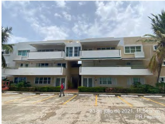
Foto 9: Lado oeste del edificio 4 también conocido como edificio D.
