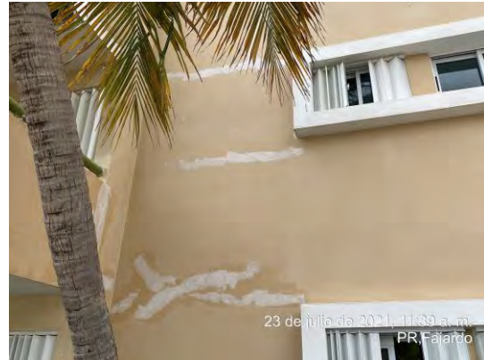
Foto 10: Se observó que se realizó reparación de grietas en el lado oeste del edificio.
