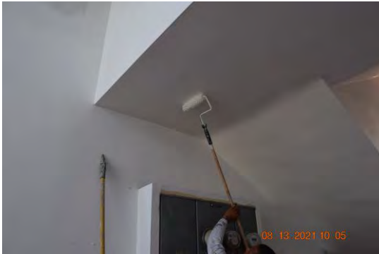
Foto 3: Se observó trabajador realizando labor de pintura en el interior del edificio.
