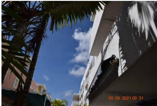
Foto 3: Se observaron trabajadores realizando labor de aplicación de segunda capa de pintura en el lado oeste del edificio 5 (E).
