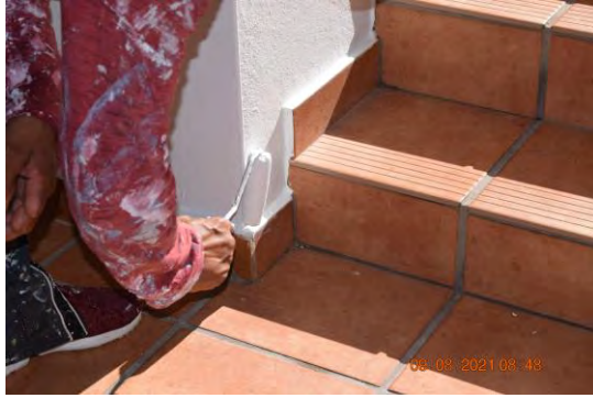
Foto 5: Se observaron trabajadores realizando labores de aplicación de pintura en los recortes de los muros del edificio 3 (C).
