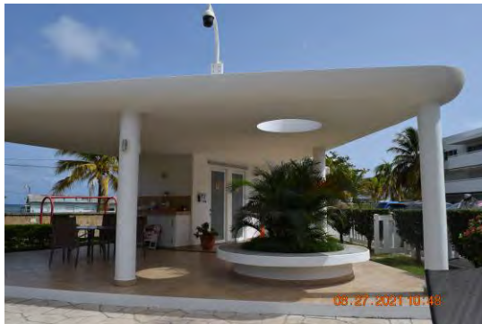
Foto 5: Se observó el edificio de los baños del área común de la piscina terminado completamente con labores de pintura.
