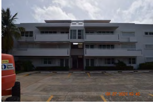
Foto 1: Perspectiva del lado este del edificio 5 (E).
