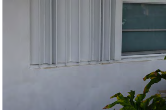
Foto 10: Se observó aplicación de calafateo alrededor de los marcos de las ventanas y aplicación de primer en la fachada frontal del edificio.
