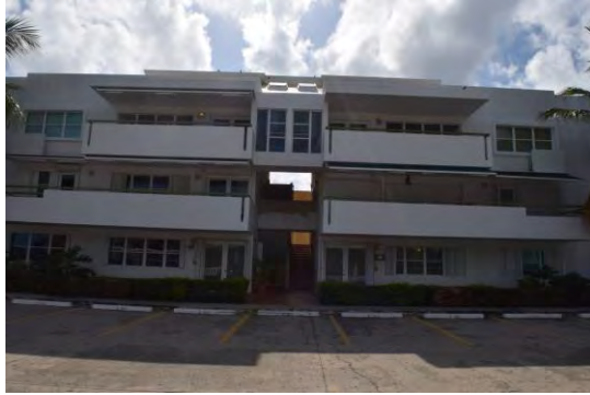
Foto 9: Fachada frontal del edificio 4 (D).
