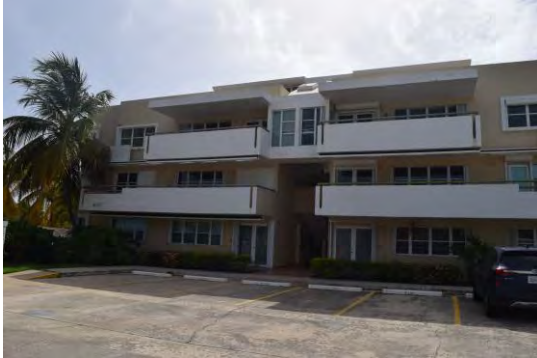
Foto 1: Se observó limpieza realizada en el edificio 5 (E).
