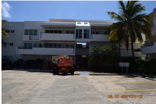
Foto 1: Fachada frontal del edificio 3 (C).
