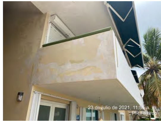
Foto 12: Se observó que se realizó reparación de grietas en el lado oeste del edificio.
