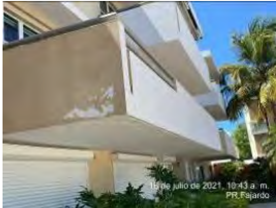
Foto 9: El contratista SP no estaba en el área de trabajo, se observó que realizó limpieza con máquina de presión en el lado este del complejo.
