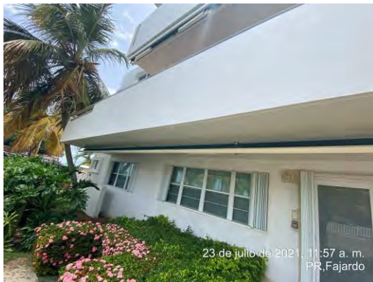
Foto 16: Se observó que se realizó aplicación de primer en el lado oeste del edificio.
